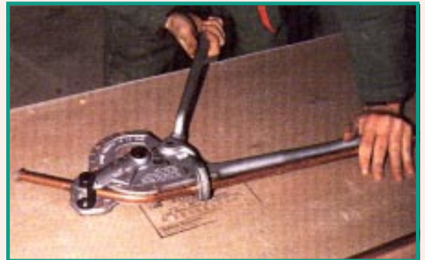
FIGURA 3.1. doblado de tubos de cobre
