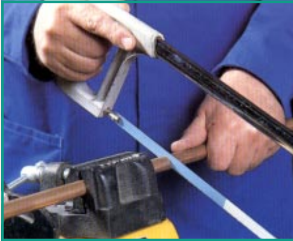
FIGURA 3.25. corte del tubo de cobre
