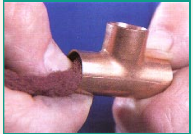
FIGURA 3.27. limpieza interior del accesorio
