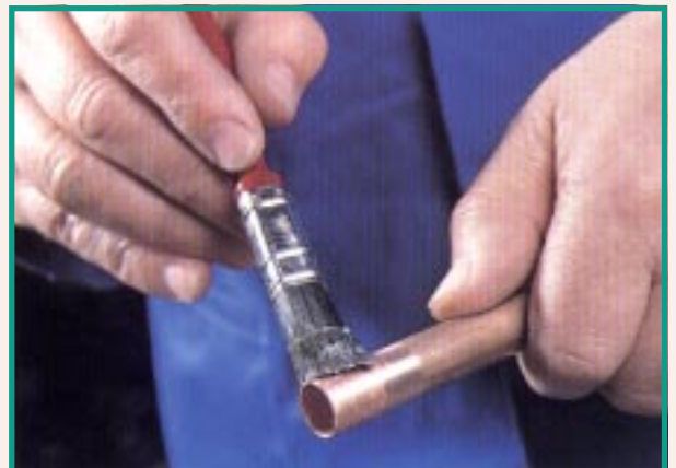
FIGURA 3.29. aplicación del fundente
