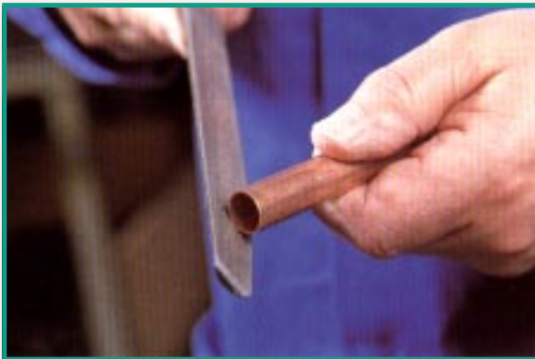
FIGURA 3.26. eliminación de rebabas
