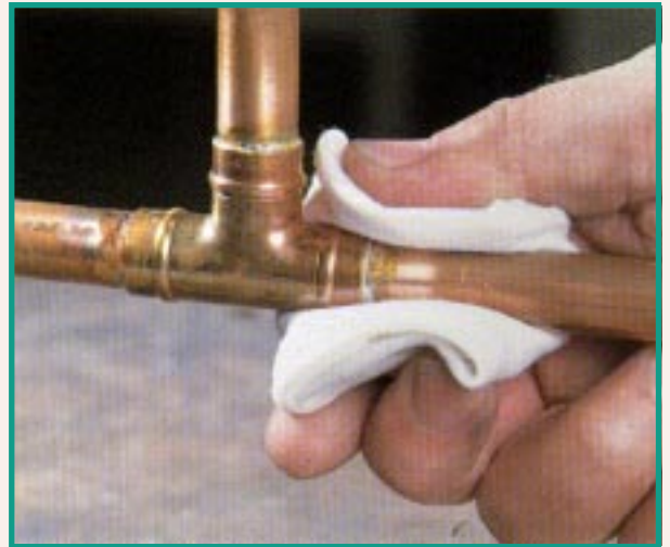
FIGURA 3.32. limpieza de la soldadura
