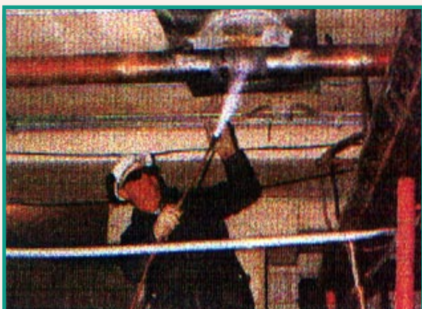
FIGURA 3.16. soldadura fuerte en cañerías para gases de hospital
