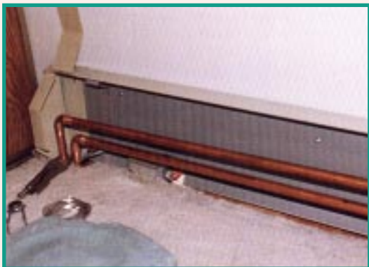
FIGURA 2.8. Instalación de tubos de cobre Tipo \frac{3}{4} L como base para radiadores por convección
