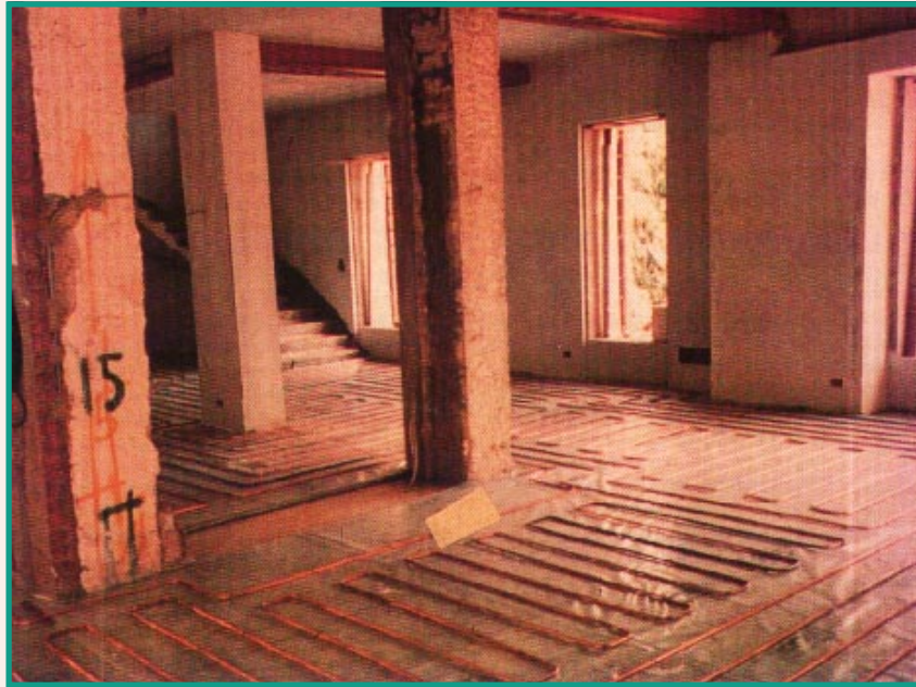
FIGURA 2.17. instalación de losa radiante
