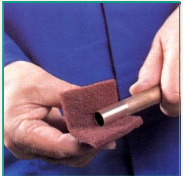
FIGURA 3.28. limpieza del extremo del tubo
