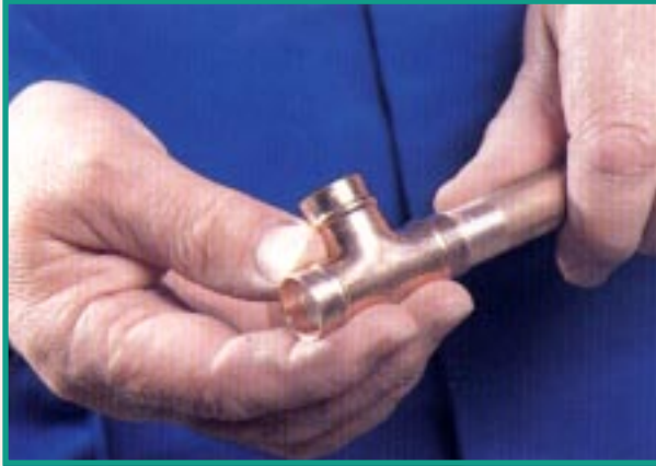
FIGURA 3.30. unión del tubo y el accesorio
