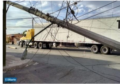
Acción humana: Accidente corta suministro eléctrico,
